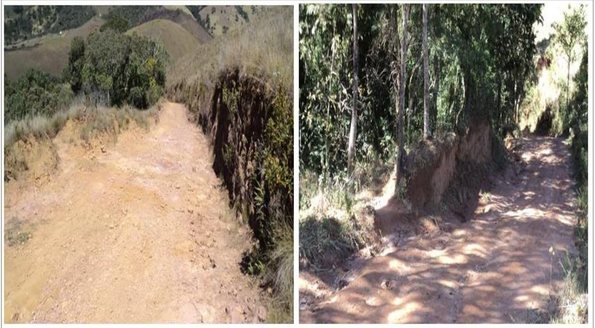
Figura 13 - Conservação das estradas.
