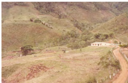
Figura 25- Fotografia da Fundação da Escola.
